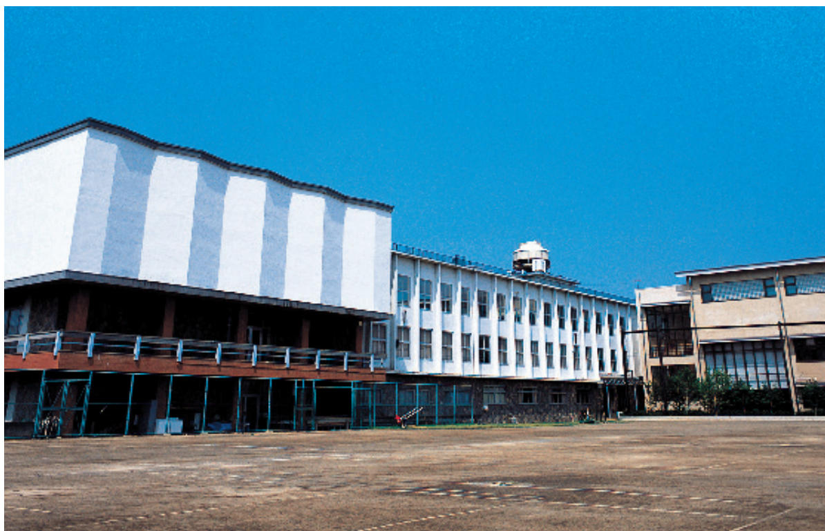
校庭から見る校舎
